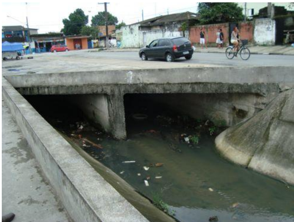
Foto 2-45: Início do canal do Rio Acaraú com vista para montante na Av. Vicente de Carvalho.
