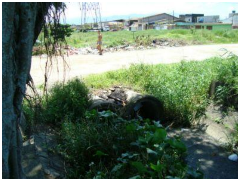
Foto 2-26: Passagem sob a Av. Bento Pedro da Costa.
