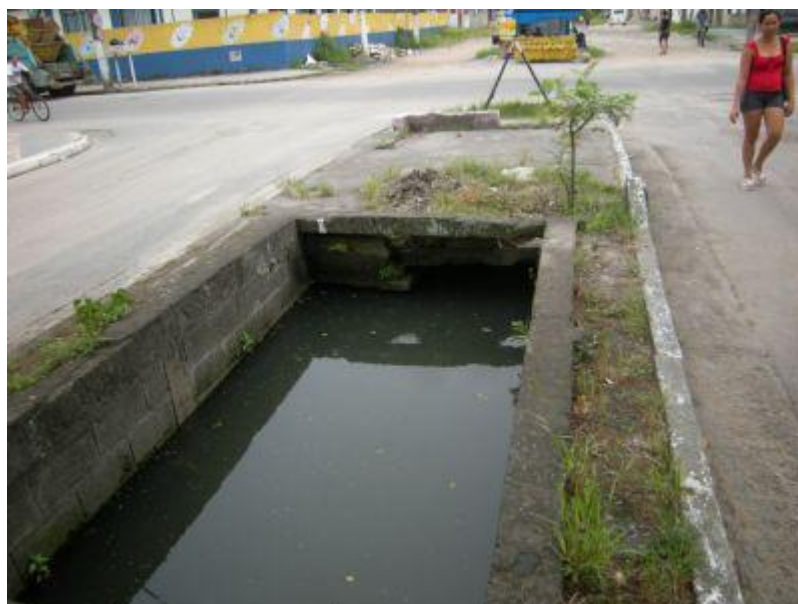
2-7: Canal de concreto da Rua Arnaldo Gimenez com a Al. das Violetas com vista para jusante
