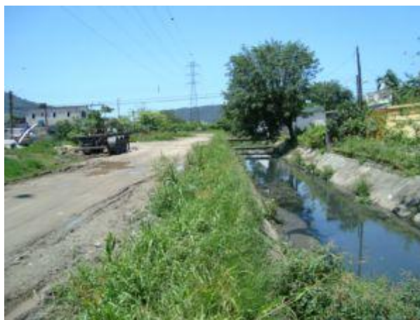
Foto 2-23: Canal da bacia BE com vista para jusante com vista da Rua Edvaldo Pires.
