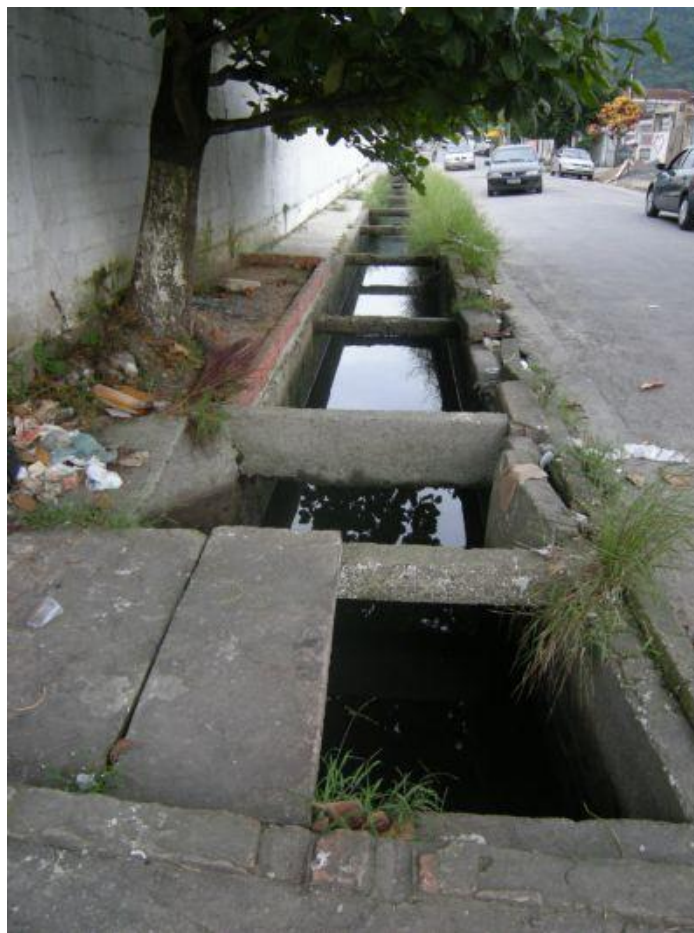
Foto 2-6: Canal da Rua Paulo Orlandi a partir da Al. das Violetas com vista para montante.
