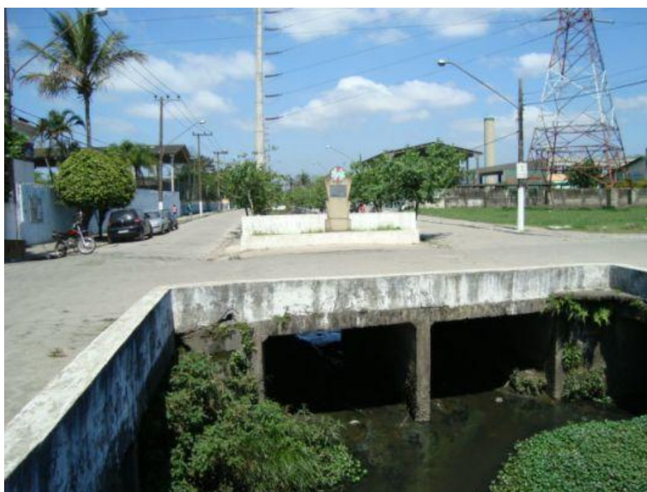
Foto 2-15: Aduela dupla no final da canal da Av. Adriano Dias dos Santos com vista para montante da Av. Mario Daige.
