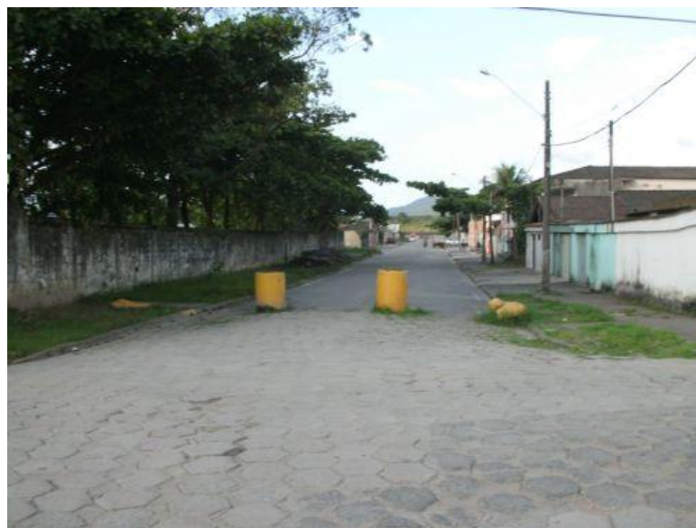
Foto 2-13: Rua Manoel Marques Naberto, local de alagamentos frequentes
