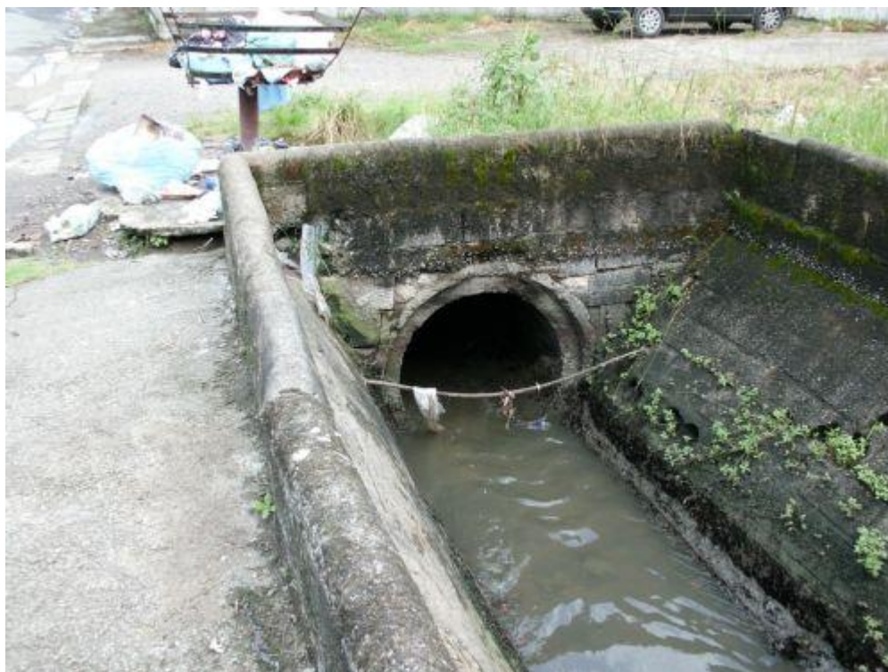
Foto 2-34: Trecho 5 – Fim do Canal trapezoidal de concreto na Rua João Silveira onde começa a tubulação de concreto que desemboca no Rio do Meio.
