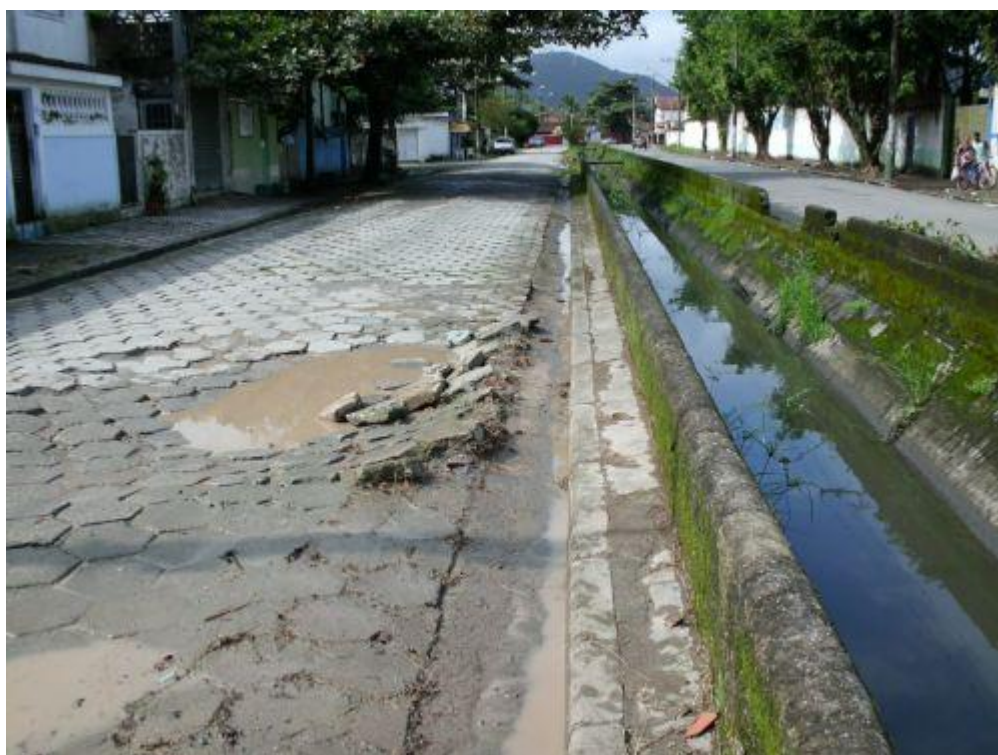
Foto 2-33: Trecho 4: - Canal trapezoidal de concreto na Rua Antonio Correa, vista para jusante da Rua Panaiotis Musculus
