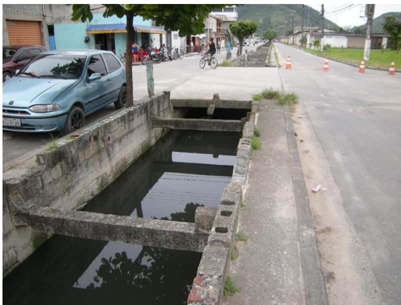
2-9: Canal da Rua das Magnólias com vista para montante na altura da Al. José Nunes Teixeira.
