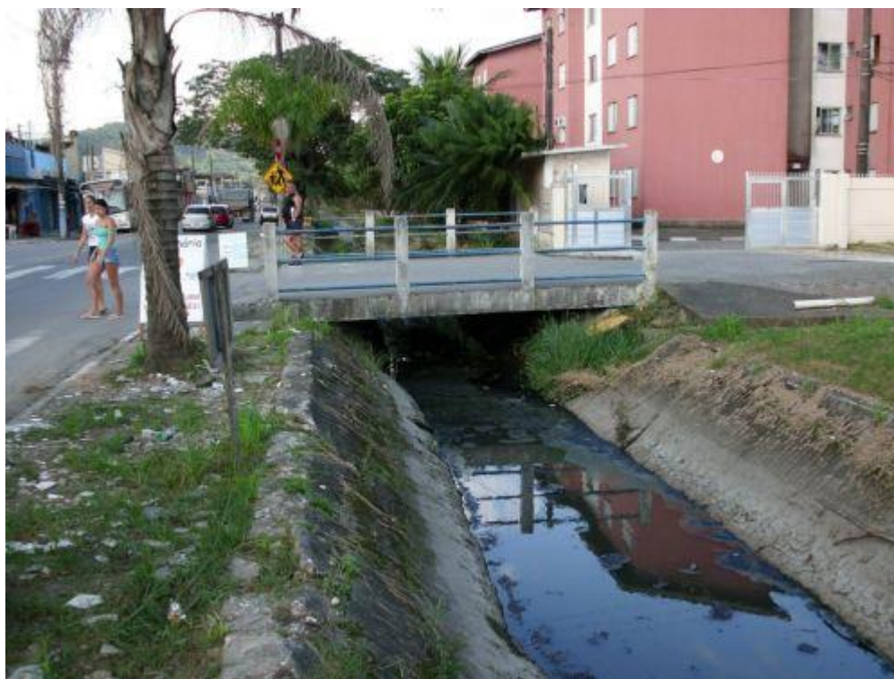
Foto 2-39: Vista para jusante Canal da Av. Antenor Pimentel.
