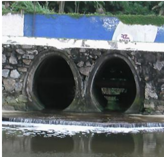
Foto 2-46: Passagem sob a Av. Miguel Stéfano
