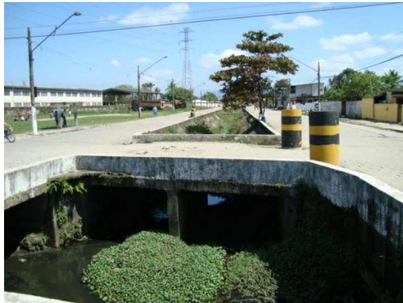
2-11: Aduela dupla de concreto no cruzamento da Av. Mario Daige com a Rua Adriano Dias dos Santos com vista para montante.
