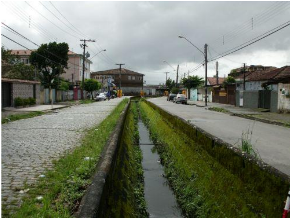
Foto 2-30: Trecho1 – Canal trapezoidal de concreto na Rua Antonio Correa, vista para montante.
