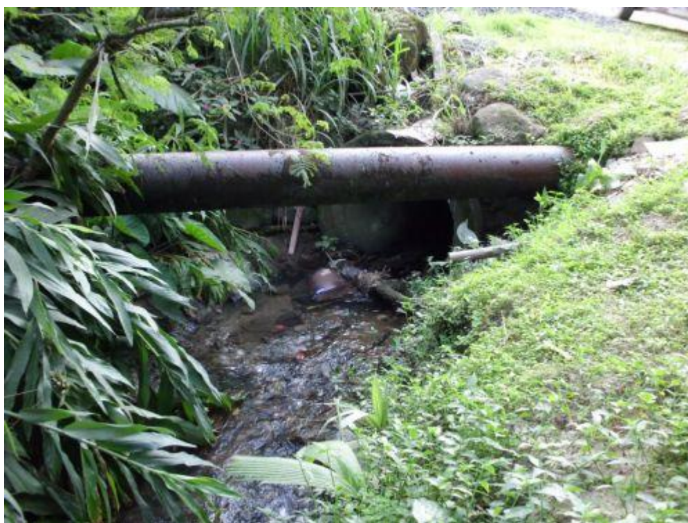
2-1: Tubo de concreto Ø0,80m próximo à Rua Onze.
