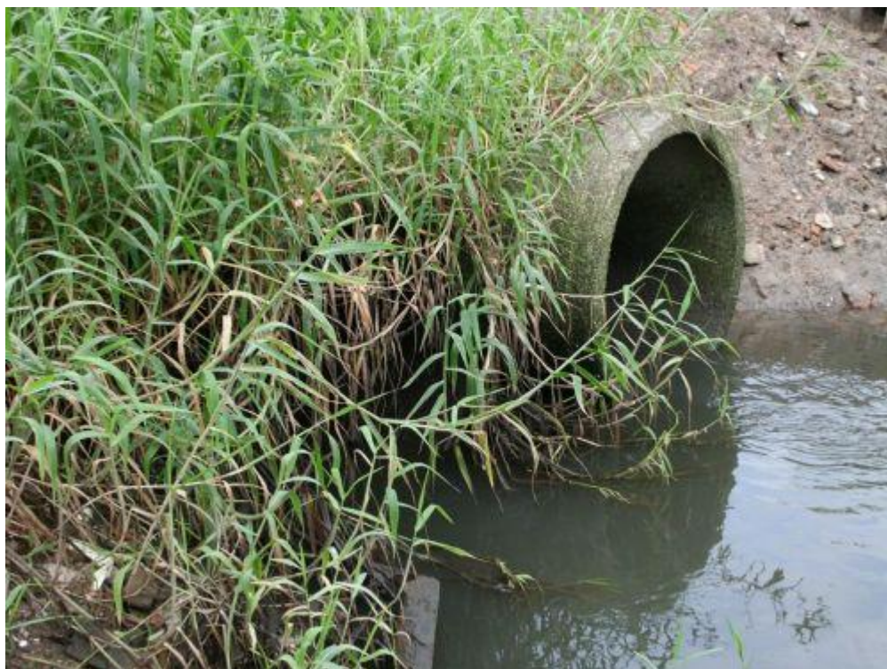
Foto 2-32: Trecho 3 – Saída de tubo de concreto no Rio do Meio.
