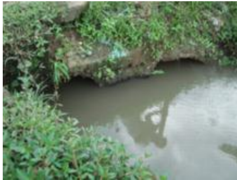
Foto 2-37: Início do canal nas proximidades da Rua Alagoas com vista para montante.
