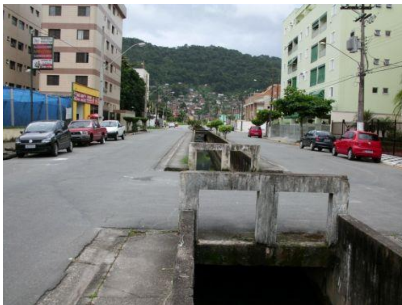
Foto 2-47: Canal da Av. Abílio dos Santos Branco da Rua Alberto Quatrini Bianchi com vista para montante
