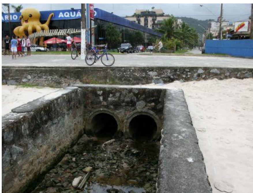
Foto 2-48: Saída do canal da Bacia E3 com vista para montante da praia da Enseada.
