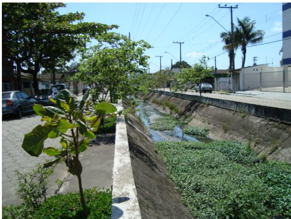
Foto 2-14: Canal da Av. Adriano Dias dos Santos da Rua Antonio da Quinta com vista para jusante.
