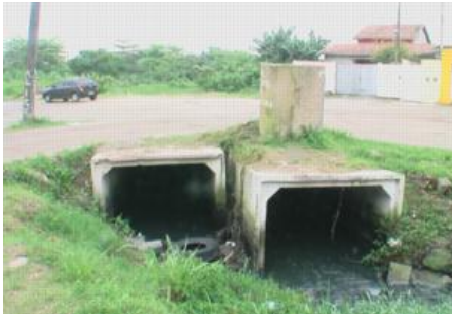
Foto 2-35: Aduelas de concreto armado da Rua Gino Fabris.
