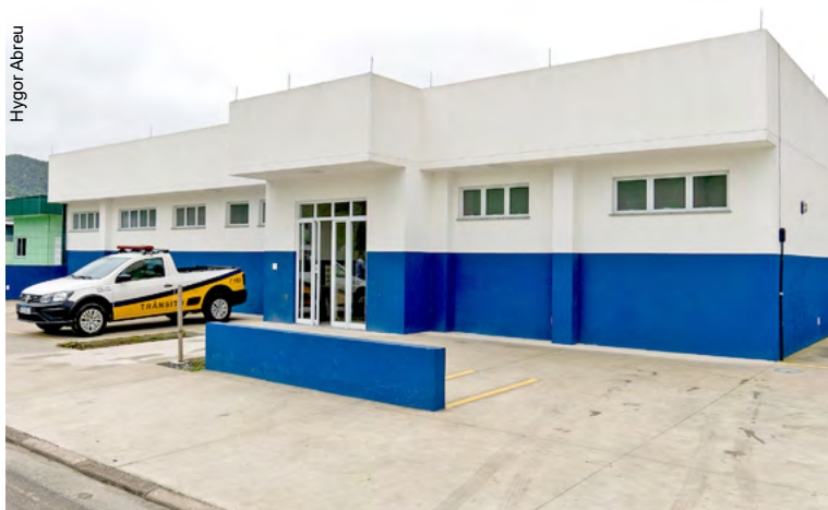
Nova base tem 170 metros quadrados, divididos em salas de comando, administrativa e arquivo, vestiários, banheiros, copa e garagem
